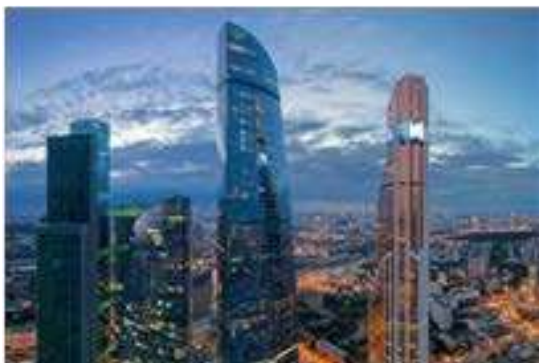
ФК «Федерация» (башня «Восток») в Москве (373,7 м).
